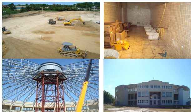
Coliseo de Aguada en construcción
